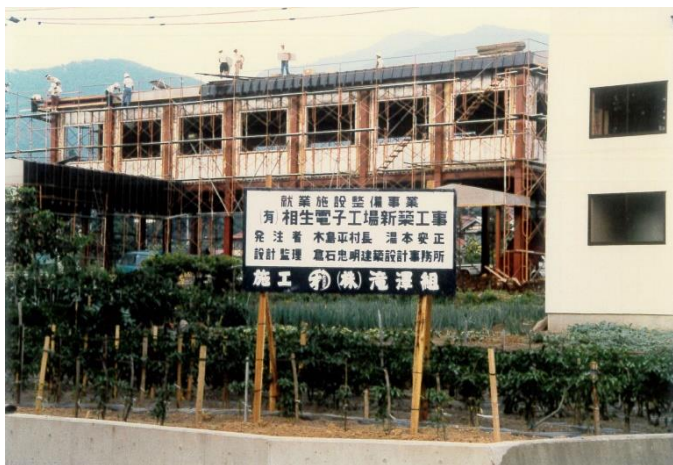
保育園建屋の隣に工場を新築（1985 年）
