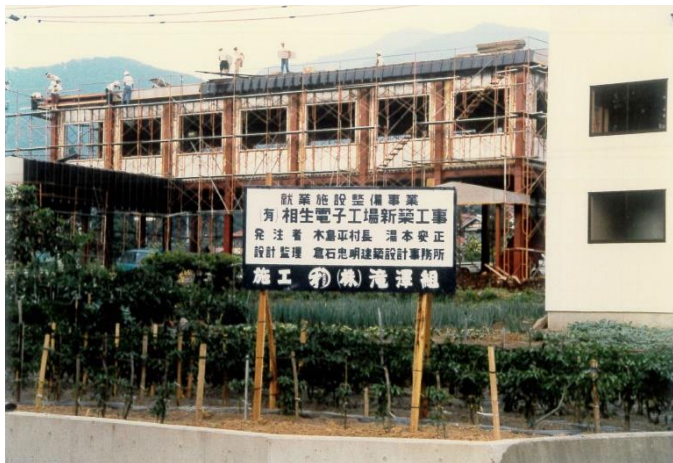
保育園建屋の隣に工場を新築（1985年）
